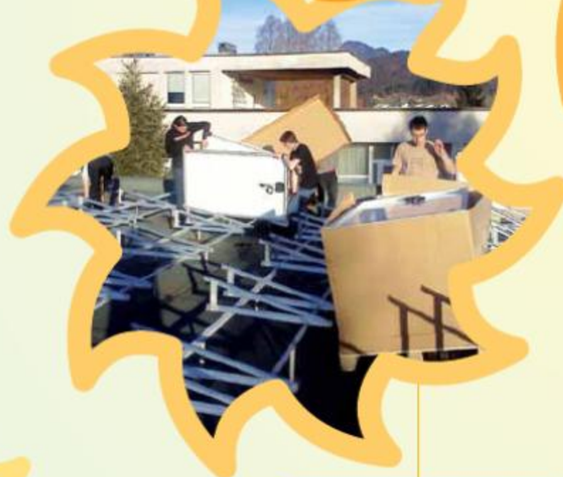
Polkristalne module so nato namestili na pripravljeno ogrodje.
